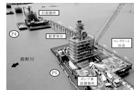
図-4 コンクリート圧送状況
