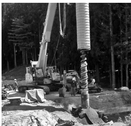
図-2 ケーシング連行型工法（SMB工法）
