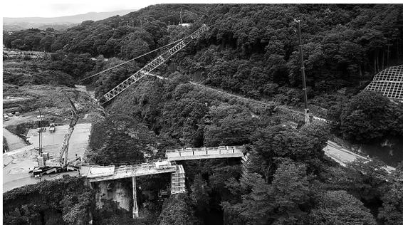
図-2 主桁撤去状況
