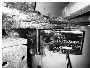
図-3 ボルトの再交換
