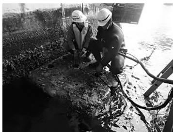
図-4 静的破碎油圧工法施工状況
