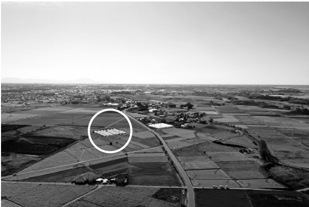
図-1 着工前 (○印：ビニールハウス)
