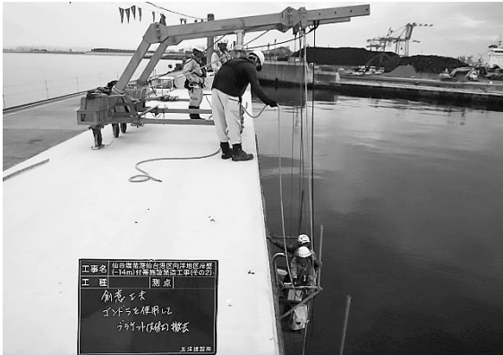
図-1 台車式ゴンドラによる ブラケット撤去状況
