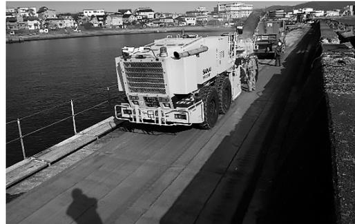
図-4 自走式大型切削機 施工状況
