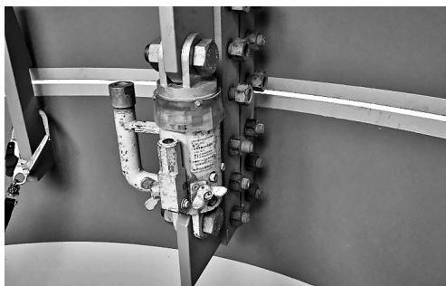
図-3 柱建入調整治具「建治君」
