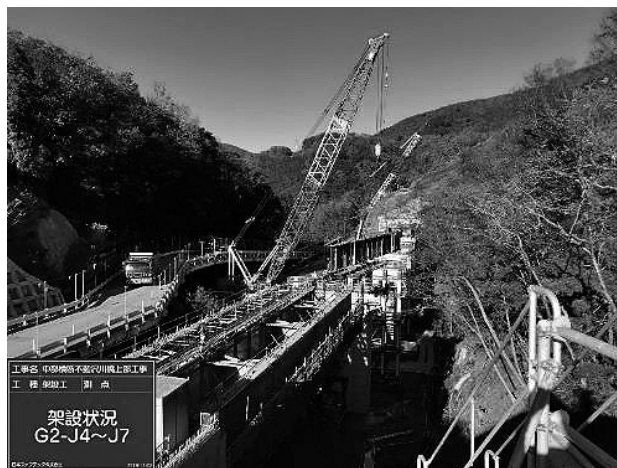
図-4 2班同時架設 (手前：仮栈橋上)
