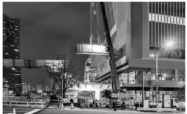
図-4 手延べ桁解体状況
