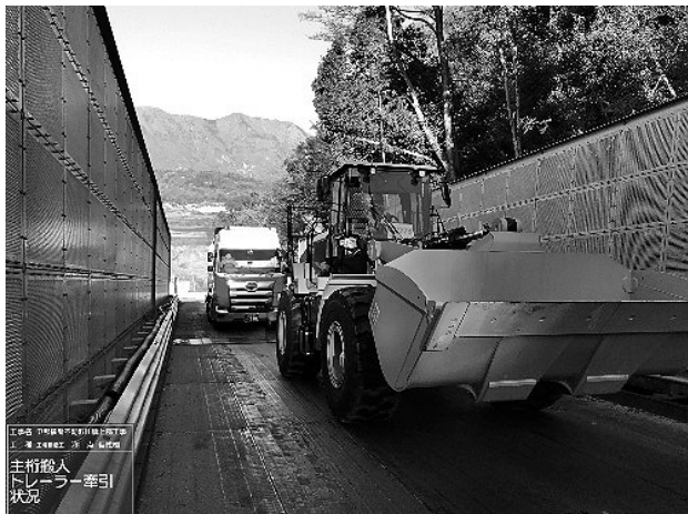
図-7 トレーラけん引状況
