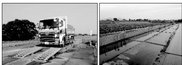
図-2 湿式タイヤ洗浄装置と散水状況
