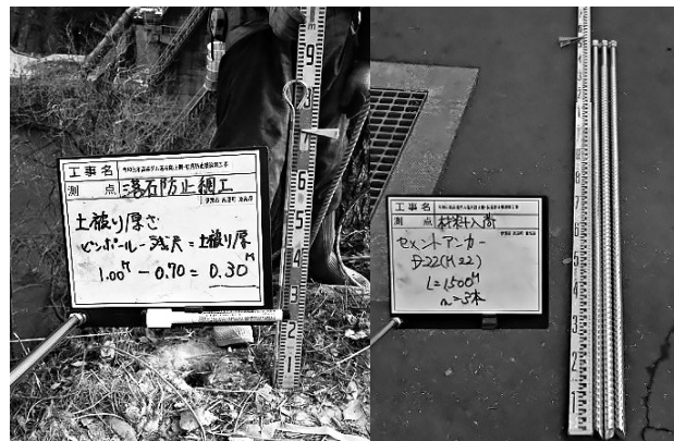
図-1 土被り部厚さ検測と使用アンカー
