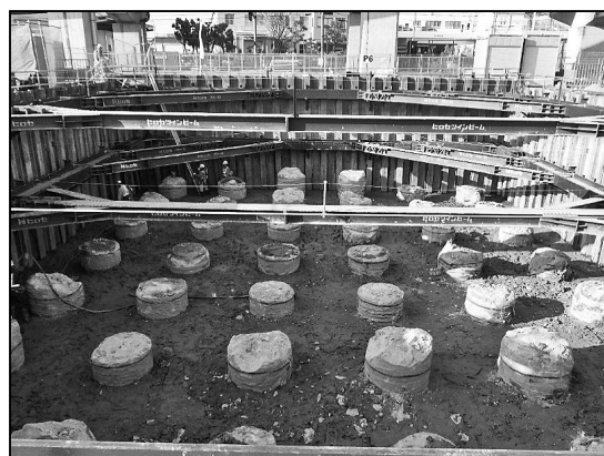
図-6 床付け完了状況 (P6)
