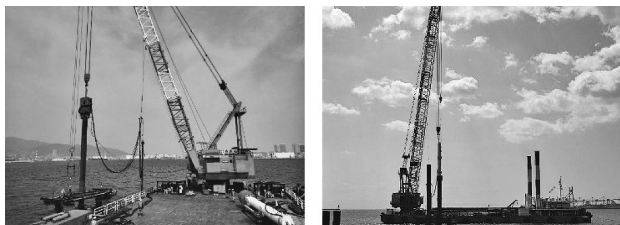
図-6 鋼管杭打設状況
