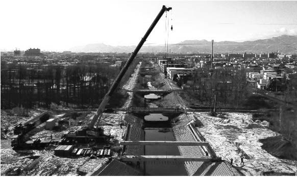
図-4 架設状況 ステップ1
