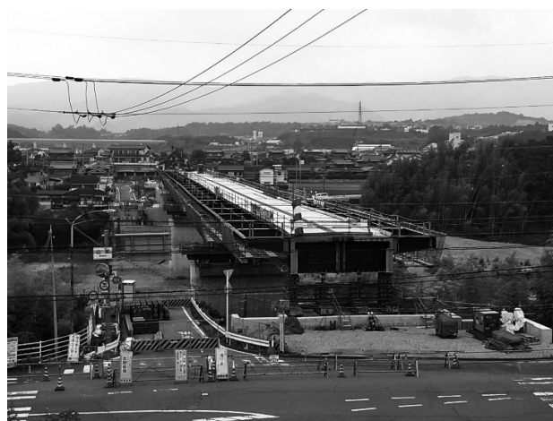
図-4 桁送出し完了
