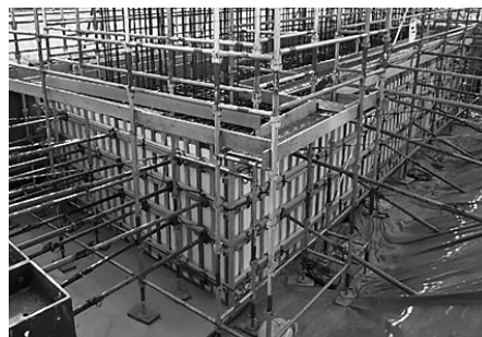
図-2 発泡スチロール設置状況
