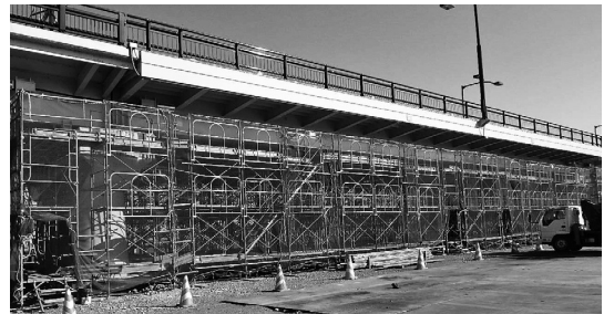
図-3 桁下全面足場設置状況
