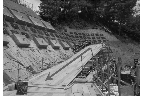
図-4 移設用 スロープ足場
