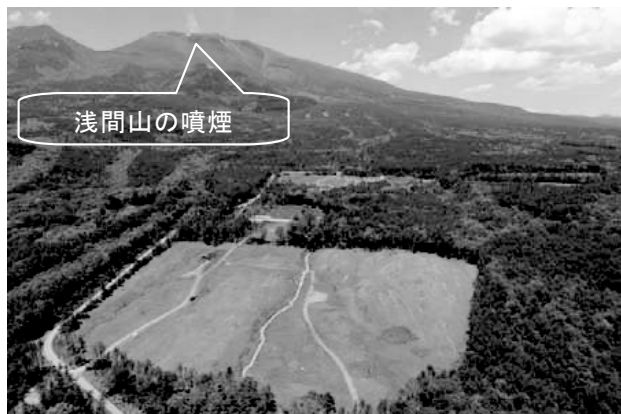
図-1 着工前状況
