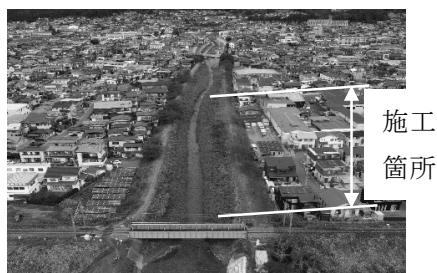
図-1 施工箇所上空全景着手前写真
