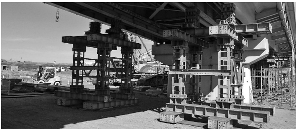
図-6 用心ベント設置状況
