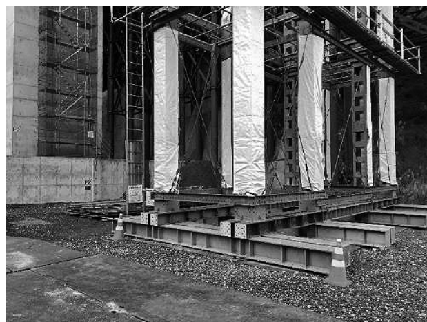
図-9 ベント基礎梁の延長状況
