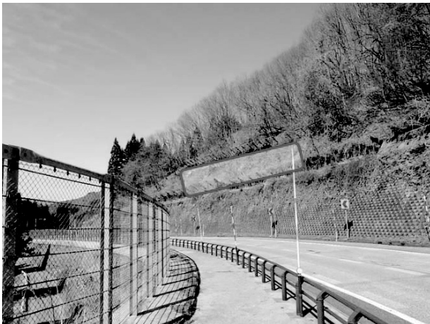
図-1 八木山現場全景
