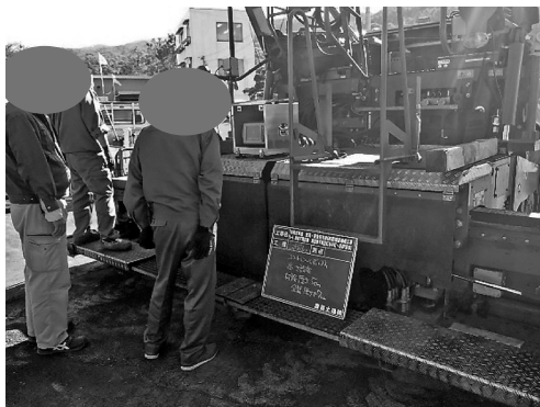
図-2 試験施工の様子
