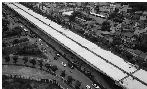
図-11 床版コン打設完了時全景
