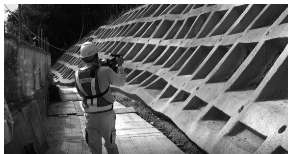
図-10 歩測式スラムレーザー手法
