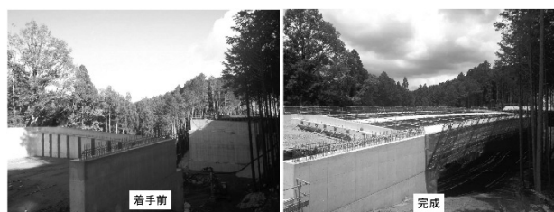
図-2 工事箇所全景
