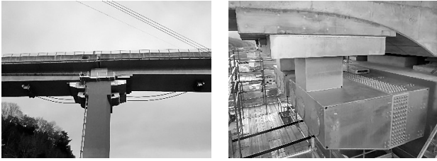
図-3 施工完了写真
