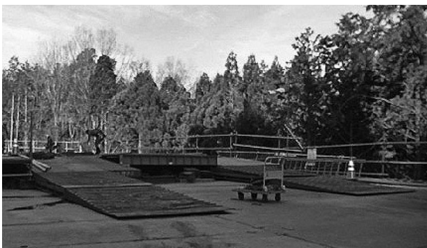
図-4 鋼製スロープ全景
