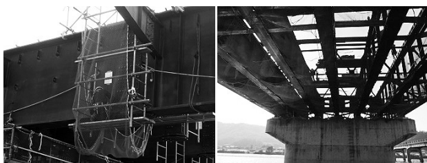
図-3 添接足場・ラッセルネット展張状況
