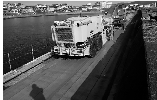
図-4 自走式大型切削機 施工状況
