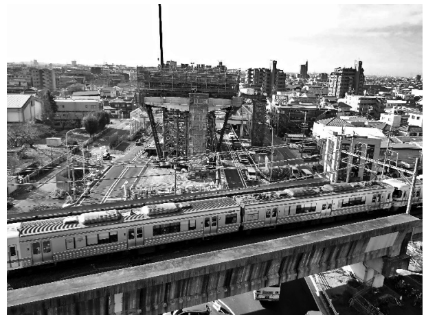
図-2 架設場所(発進側より撮影)
