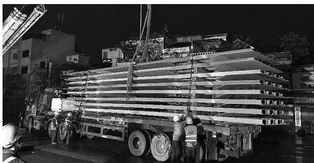
図-6 床版パネル荷卸し状況
