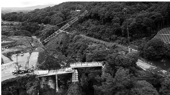
図-2 主桁撤去状況
