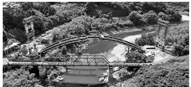
図-1 アーチリブ架設状況
