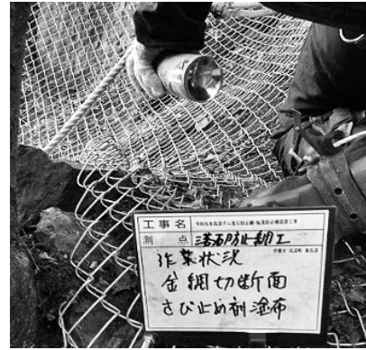
図-4 亜鉛メッキ菱形金網切断部の防錆
