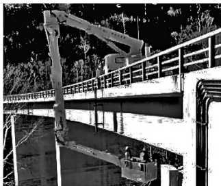
図-1 橋梁点検車による点検状況
