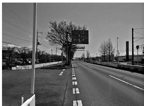
図-2 移設前の既設F型標識
