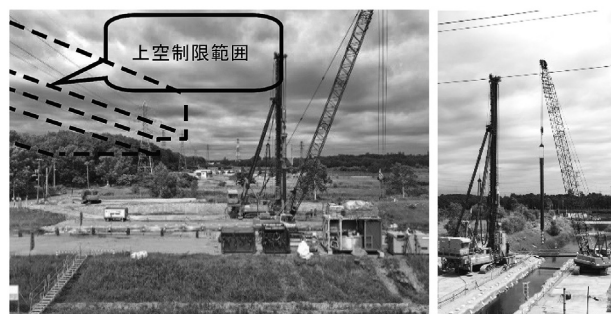
図-2 鋼管杭従来工法
