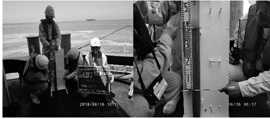
図-6 抜き取りコア厚確認
