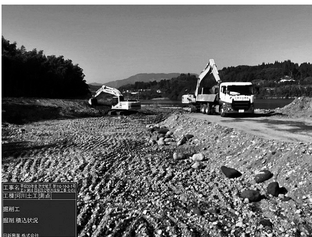
図-2 掘削・積込状況
