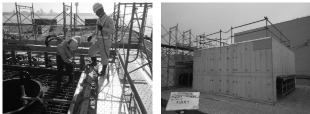
図-10 コンクリート打設状況、製作完了
