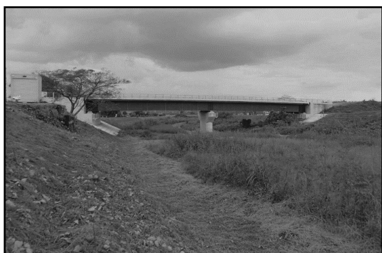
図-1 榛名白川橋梁全景
