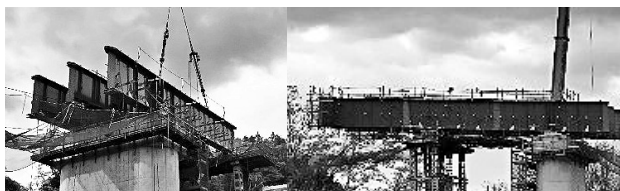
図-4 架設作業状況
