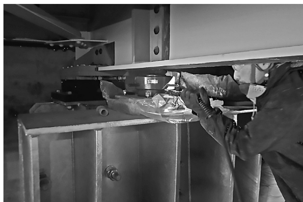
図-4 ジャッキダウン
