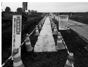
図-5 安全通路 マット敷設、カラーコーン
