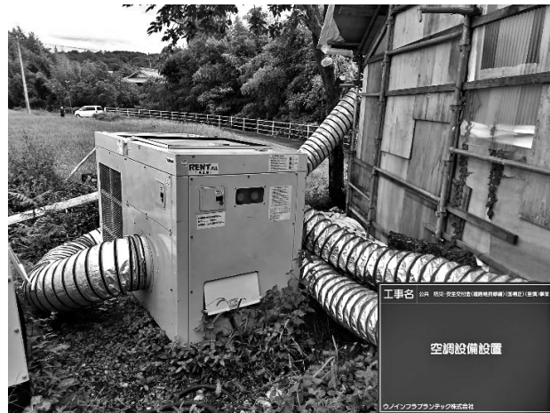
図-4 現場用エアコン設置状況2
