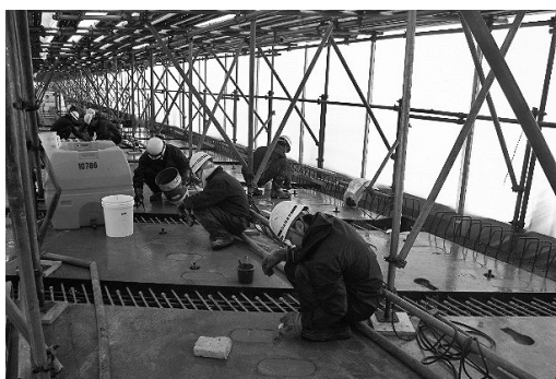
図-9 無収縮モルタル施工状況
