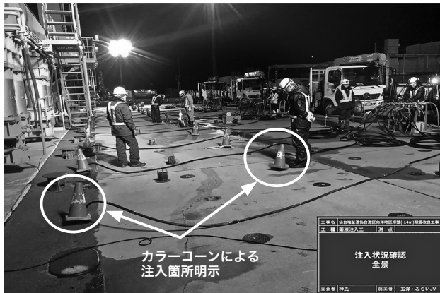
図-2 カラーコーンによる注入箇所明示
