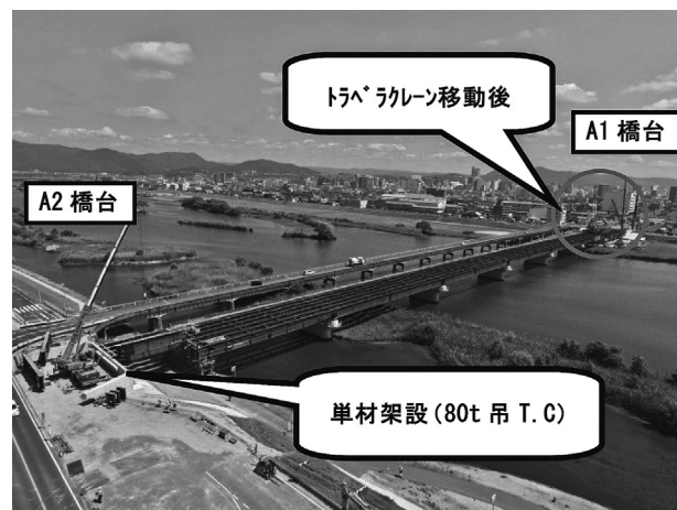
図-4 A2側単ブロック架設状況
