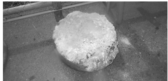
図-12 撤去したコンクリート
