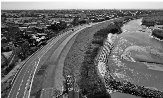
図-1 完了全景（終点側から起点側を望む）
