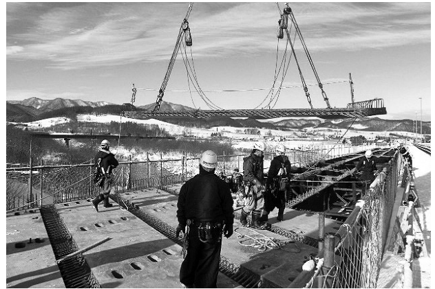
図-6 床版(SLJスラブ)架設
