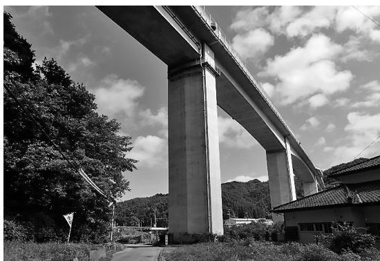
図-1 織笠高架橋全景
