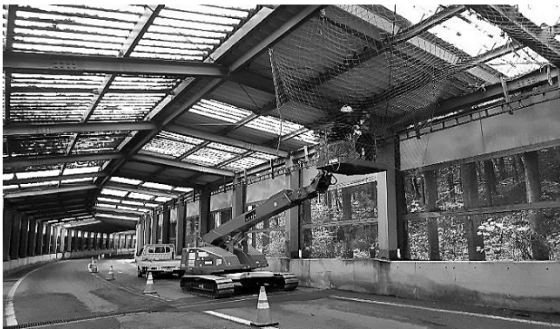
図-4 (高所作業車(クローラ型)作業状況)
