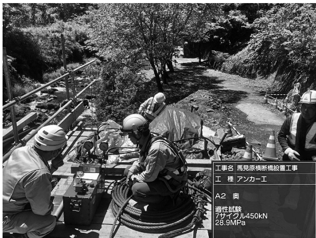
図-3 適正確認試験、アンカー定着状況
