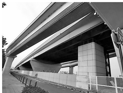
図-1 泉南マリブリッジ
