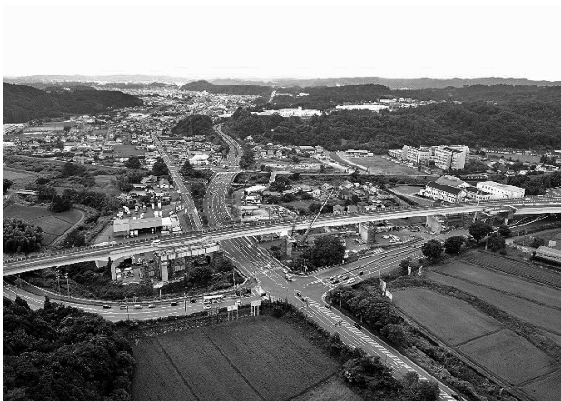
図-1 いわき中央橋 架橋地点
