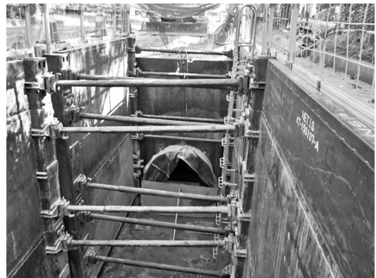
図-3 大口径長尺管埋設用簡易土留設置完了
