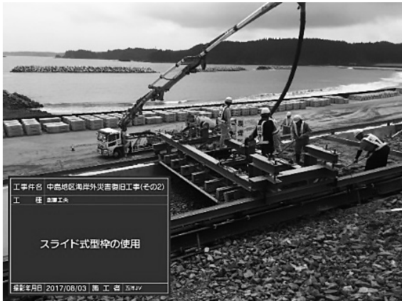
図-1 スライド式鋼製型枠使用状況
