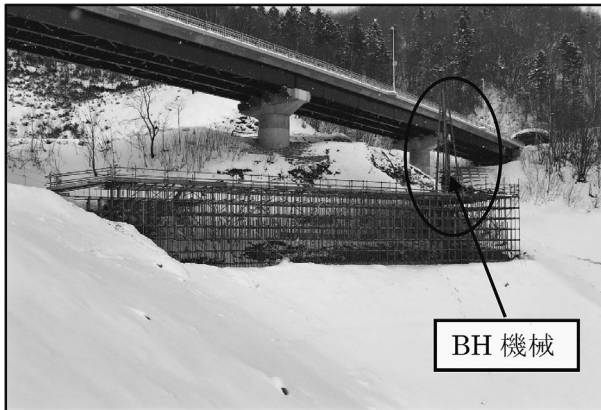
図-5 BH杭足場
