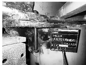
図-3 ボルトの再交換
