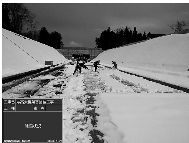
図-2 降雪時の除雪状況
