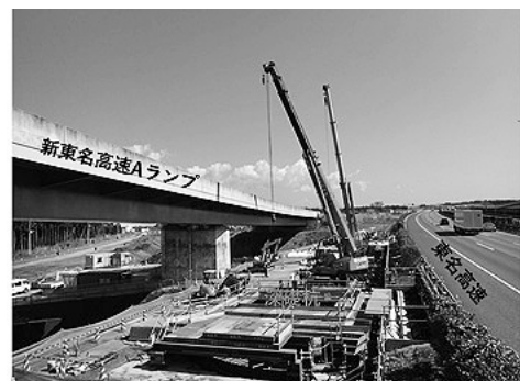
図-1 高速道路近接施工
