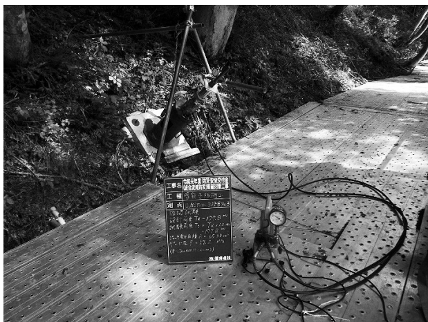
図-5 アンカー確認試験
