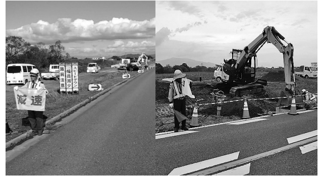
図-5 交通誘導警備員の配置
