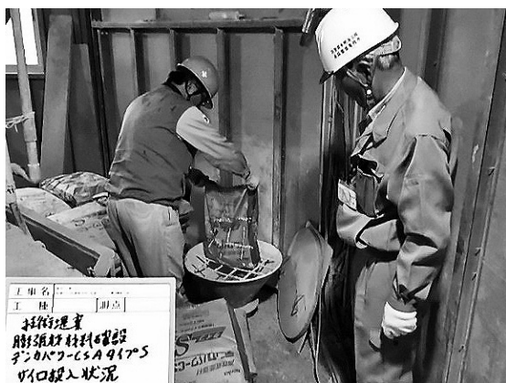
図-3 膨張材投入状況
