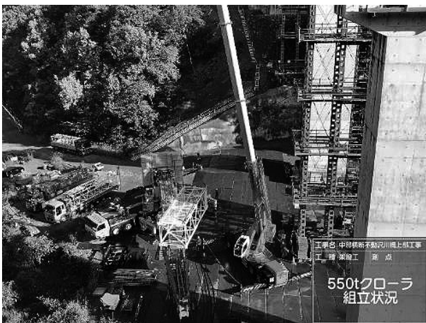
図-6 550tクレーン組立状況
