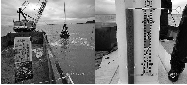
図-9 海砂投入状況 図-10 投入後コア厚確認
