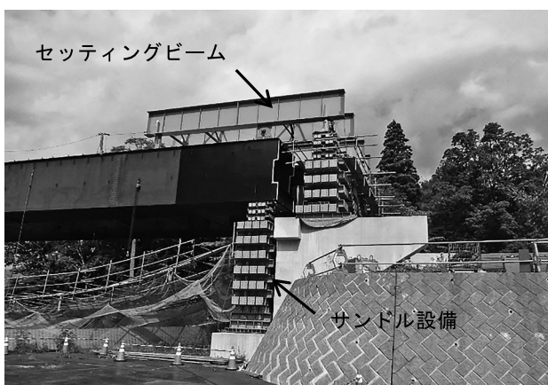
図-11 桁降下状況
