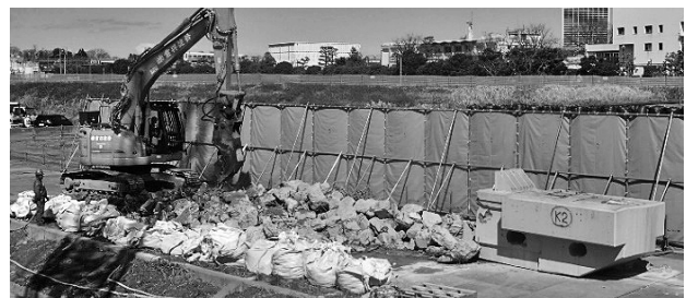
図-11 ニブラによる橋脚の破碎状況
