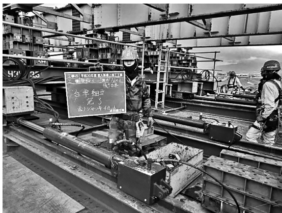
図-2 桁送り出し（台車）
