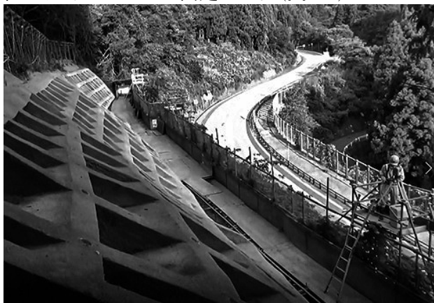
図-7 TLS計測状況
