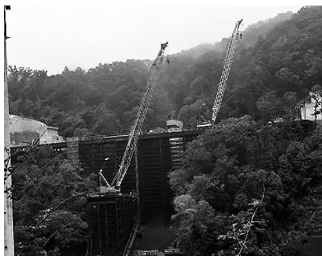
図-3 仮栈橋のクレーン使用状況
