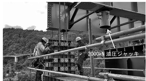
図-12 油圧ジャッキ吊り下げ状況
