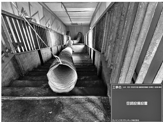
図-3 現場用エアコン設置状況1
