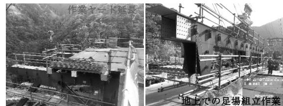
図-8 作業ヤード延長
