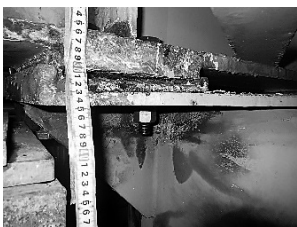
図-2 分離確認と仮復旧
