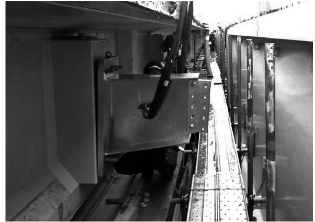
図-6 ブラケット架設状況 (Aライン)
