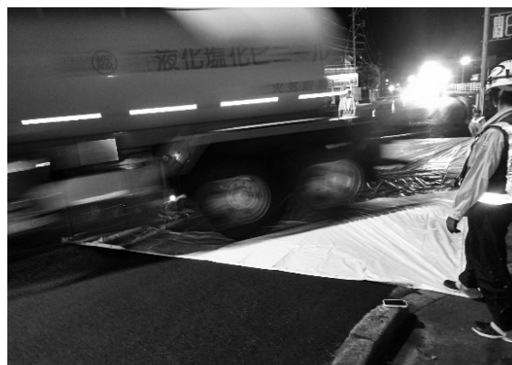
図-3 防災シートによる養生
