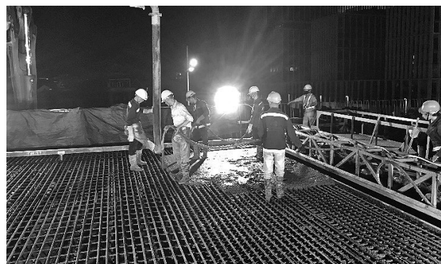
図-10 床版コンクリート打設状況
