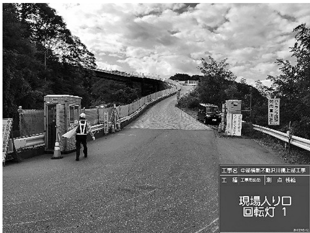
図-2 工事用道路入り口 (17.5%勾配)
