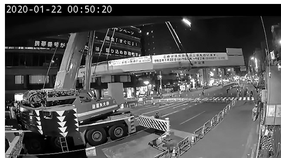
図-4 主桁撤去状況
