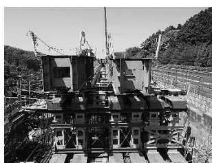
図-12 横取り状況
