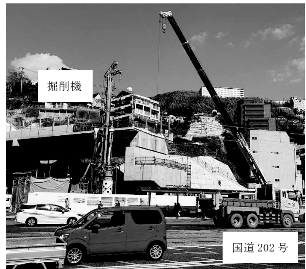
図-5 基礎杭設置状況
