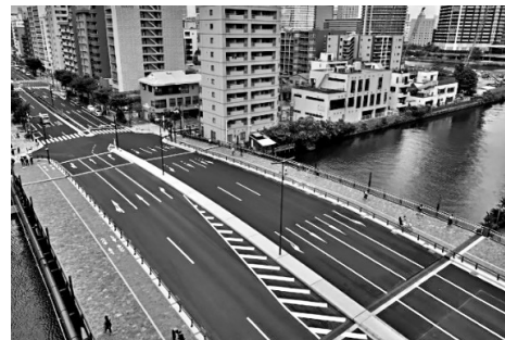
図-6 新島橋完成写真
