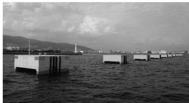
図-12 係留施設 完了
