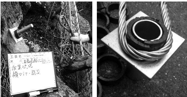
図-3 ポリエチレン管取付け状況 鋼製パイプφ32mm、ポリエチレン管径38.1mm
