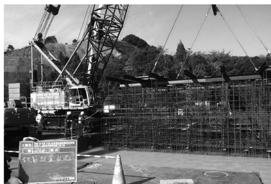
図-5 組立鉄筋据付状況
