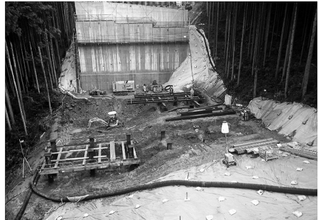
図-5 ベント支持杭打設状況
