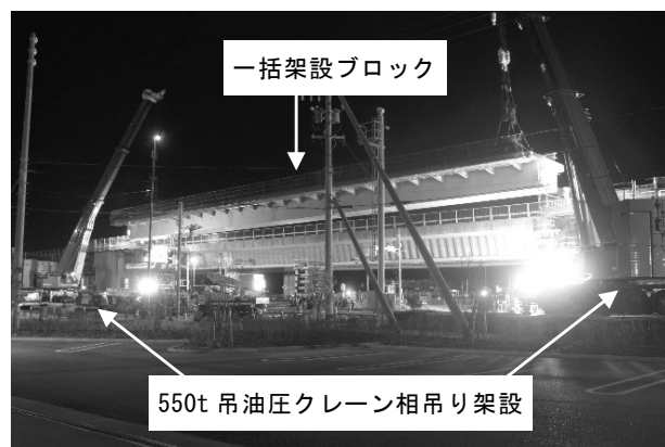
図-3 相吊り架設により一括架設
