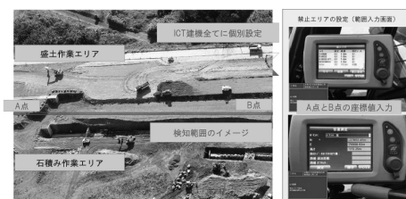
図-3 ICT建機を利用した作業分離措置
