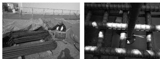
図-9 DBヘッドせん断補強鉄筋組立
