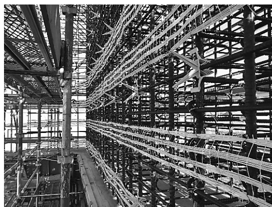
図-4 ハイパーネット設置状況
