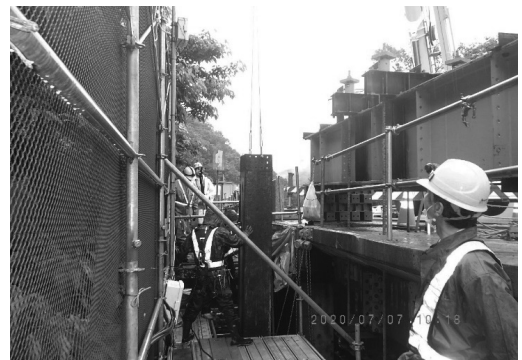
図-10 鉛直材取替の様子
