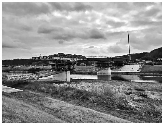
図-3 桁送り出し（全景）
