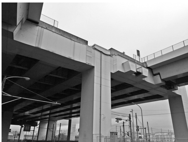
図-2 既設P1橋脚
