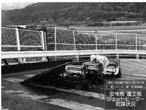
図-8 仮栈橋上のヒーターによる乾燥状況
