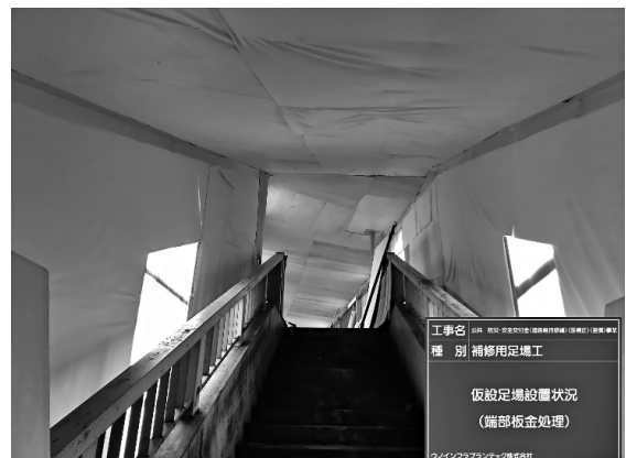
図-2 現場内密閉状況
