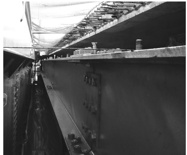
図-7 縦桁架設完了 (Bライン)
