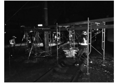
図-10 運搬設備使用状況
