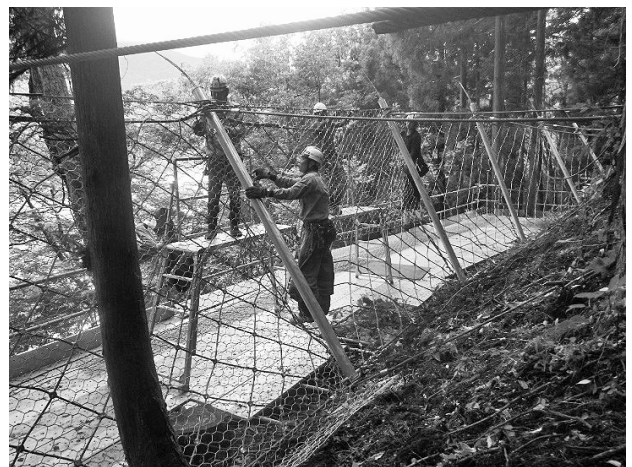
図-1 雪崩予防柵組立状況 (スノーネット)
