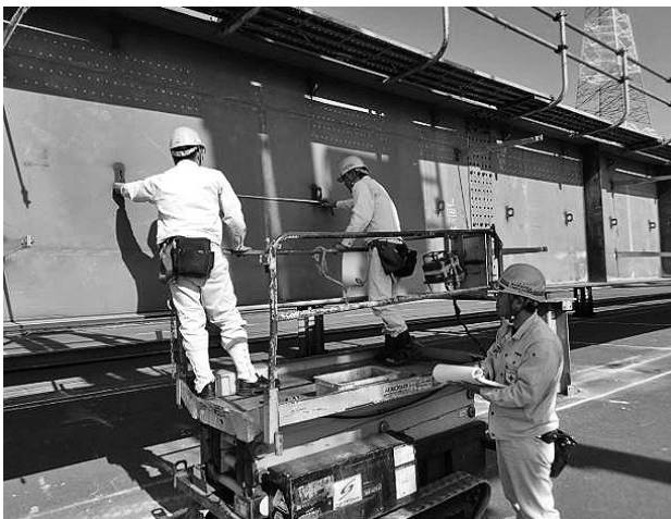
図-2 工場での金具取付間隔の測定状況
