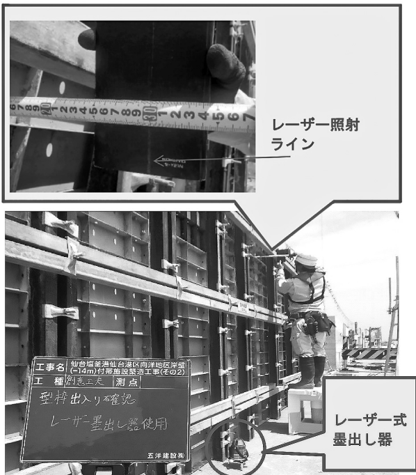
図-2 レーザー式墨出し器による型枠設置確認
