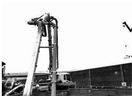
図-3 ポンプ車配管防護
