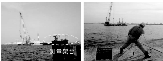
図-7 打設時誘導状況
