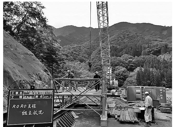
図-4 RoRo支柱組立状況
