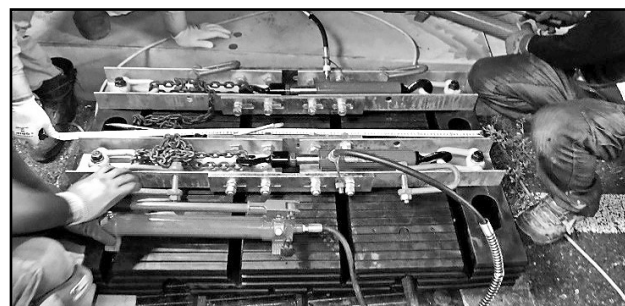
図-5 現場でのゴムジョイント圧縮作業
