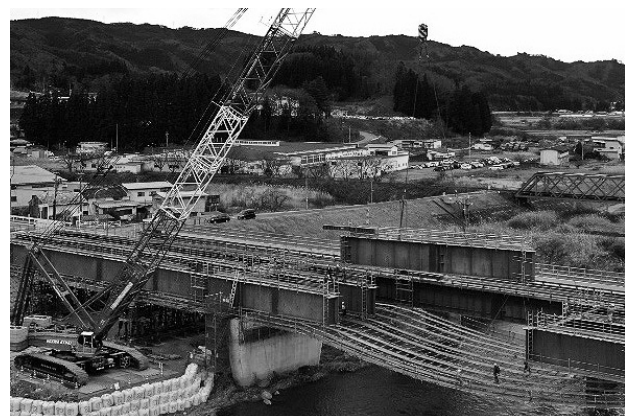
図-5 落とし込み架設状
