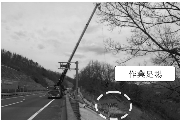
図-3 高速道路上からの資機材搬入
