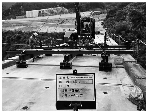
図-4 ジャッキアップ工法
