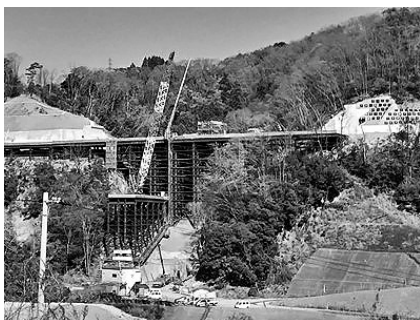
図-1 多段仮栈橋の配置状況
