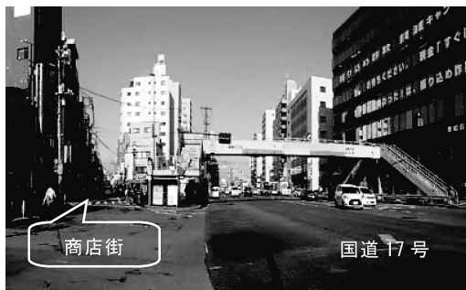
図-1 歩道橋撤去前
