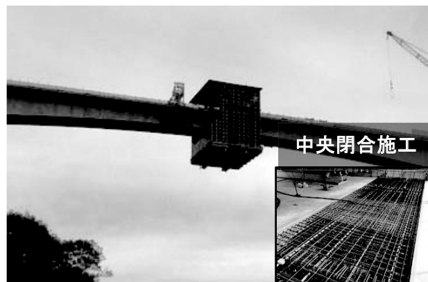
図-10 中央閉合状況
