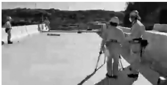
図-2 対物検査状況
