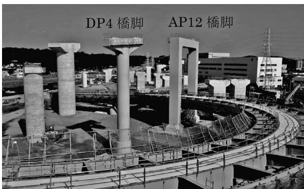
図-1 円柱橋脚DP4、ラーメン式橋脚AP12
