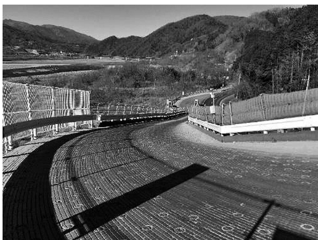
図-3 工事用道路カーブ (内側勾配29%)
