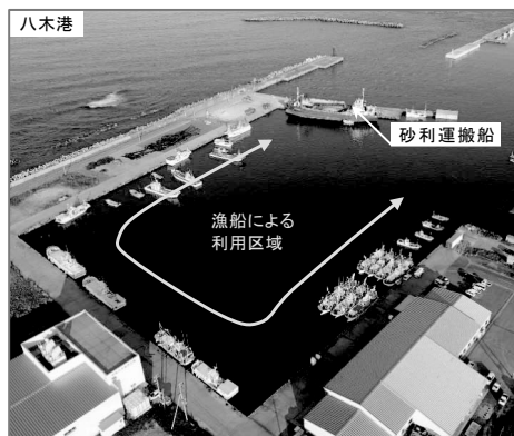
図-3 八木港の利用状況
