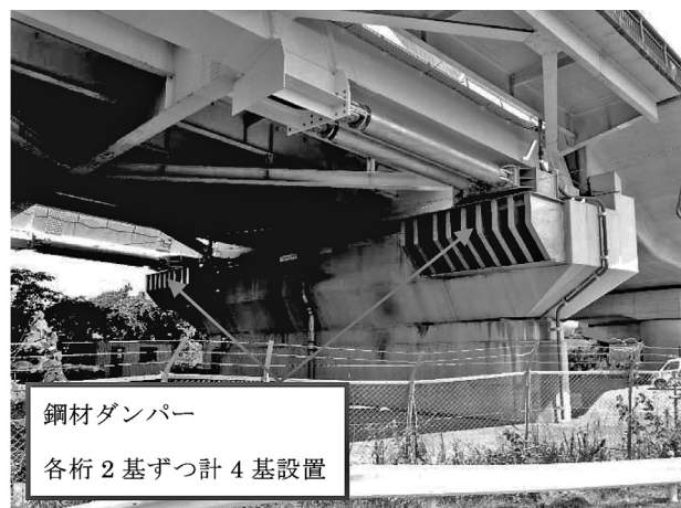
図-4 鋼材ダンパー設置状況
