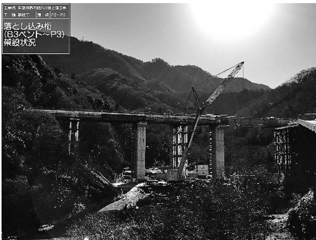
図-5 550t油圧クレーン架設状況
