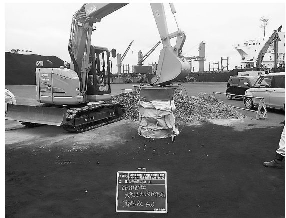
図-3 俊作による土嚢袋作成状況
