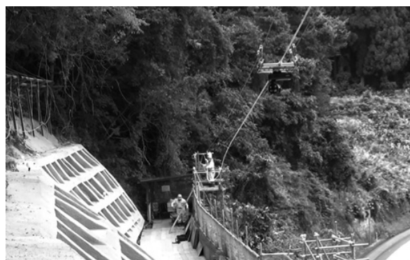
図-9 ワイヤー吊下げ式スラムレーザー手法
