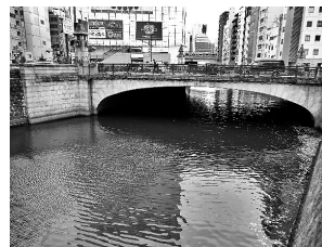
図-2 万世橋の外観
