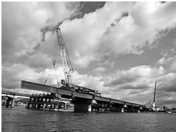
図-2 トラベラクレーン張出し架設状況
