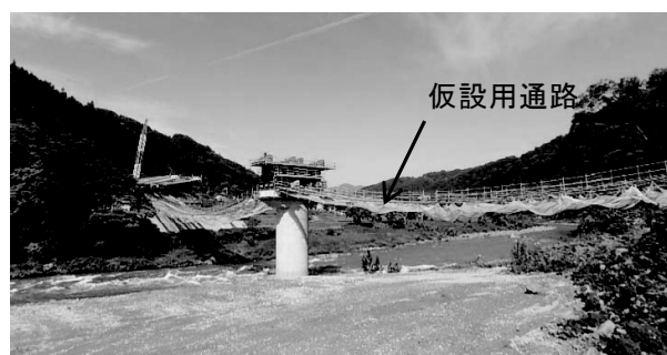
図-9 仮設用通路の設置
