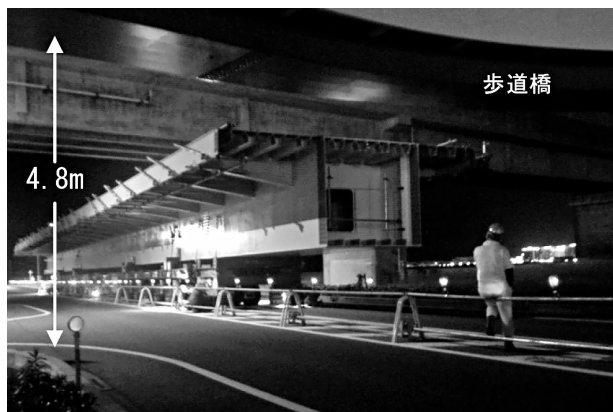
図-1 相吊り架設により一括架設
