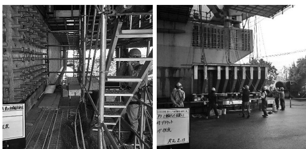
図-3 写真計測・下部工ブラケット地組立状況
