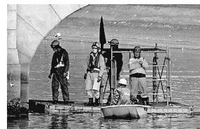
図-7 ゼニフロートXを使用した橋梁点検状況
