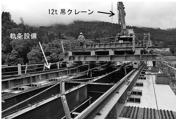
図-10 仮設備解体状況
