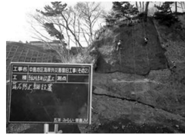
図-4 落石ネット施工状況
