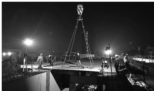
図-8 床版パネル架設状況
