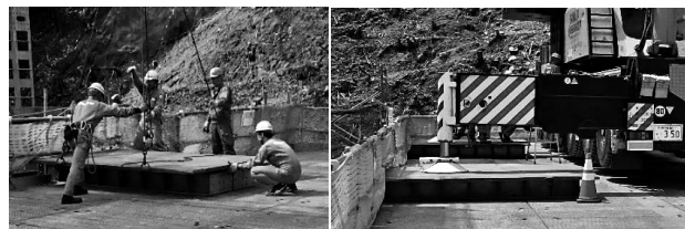
図-5 アウトリガー位置補強
