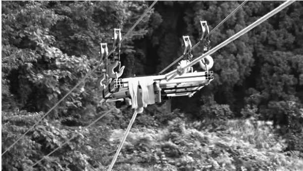
図-11 吊下げ式UAV写真測量
