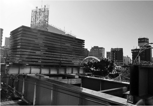
図-9 カウンターウェイト設置状況
