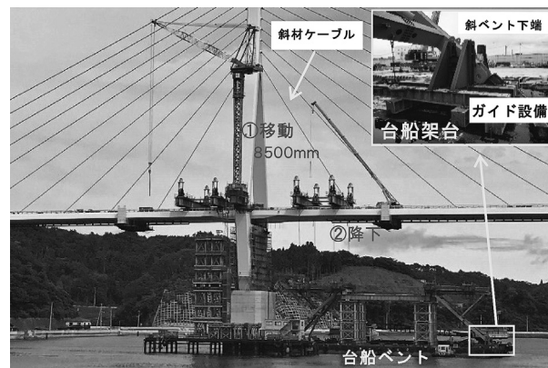
図-3 中央径間解体状況
