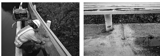
図-4 (ガードケーブル基礎部排水溝作成)
