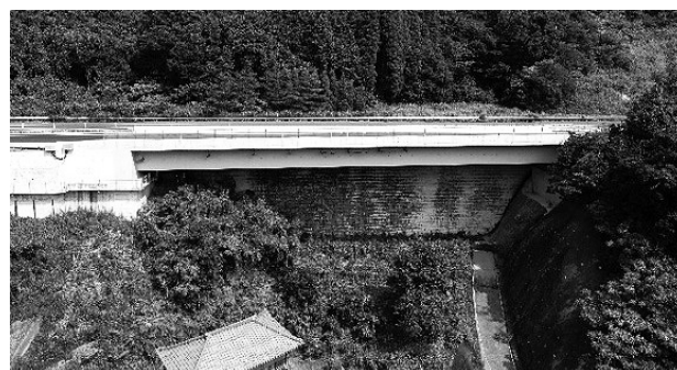
図-13 架設完了写真
