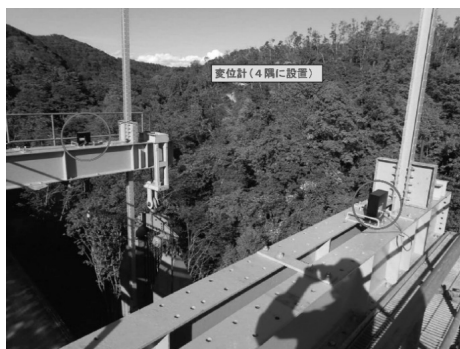
図-9 変位計設置状況
