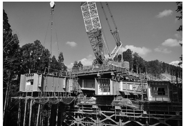
図-7 桁上覆工設置・架設状況
