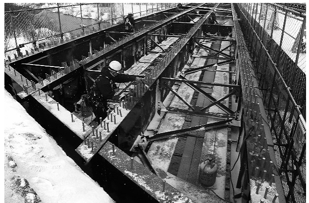
図-1 花園橋施工前
