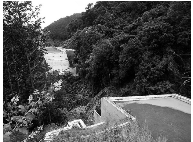
図-1 施工前状況
