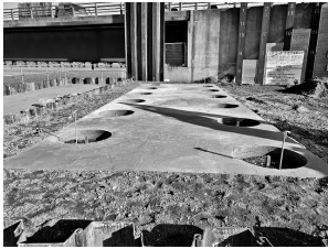
図-3 ガイドコンクリート 全景
