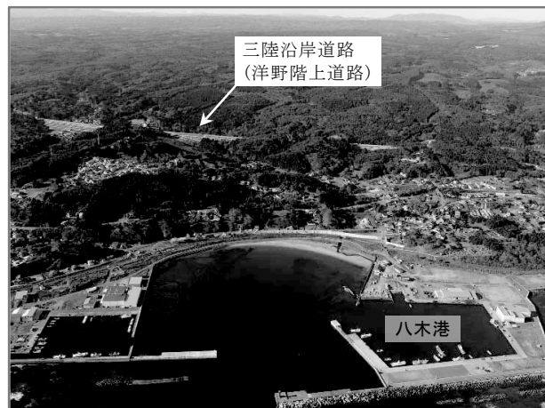
図-4 八木港から洋野階上道路を望む
