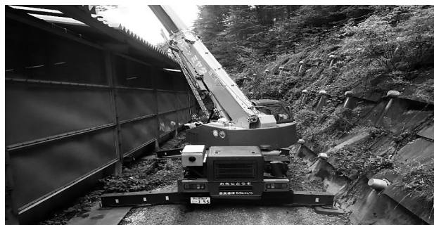
図-2 (5tクレーン設置状況)
