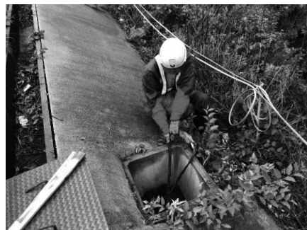
図-2 既設電線露出切廻し状況
