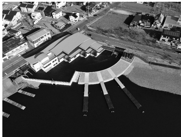
図-3 護岸工事完了
