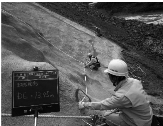
図-2 法面上での巻尺測量
