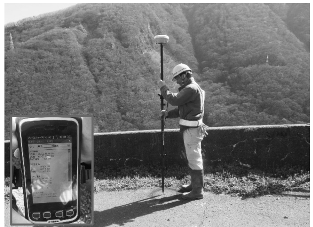
図-3 GNSSによる基準点の点検
