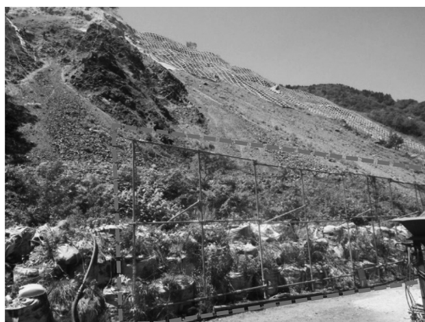
図-8 仮設落石防護柵
