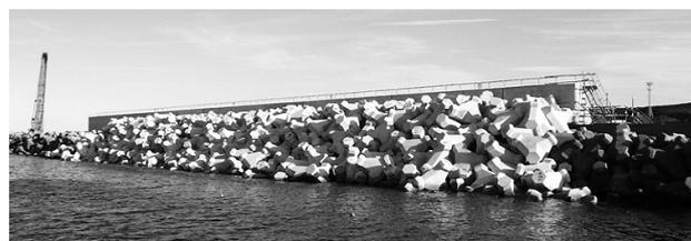
図-10 ブロック据付完了全景
