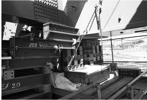
図-10 橋軸直角方向固定（実施写真）
