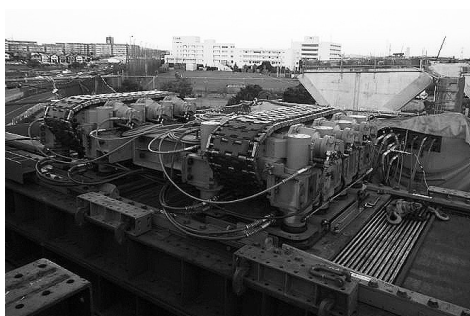
図-7 駆動式シンクロジャッキ
