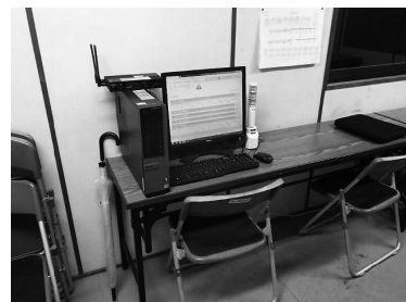
図-6 常時計測実施状況
