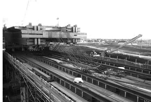
図-12 橋軸方向固定装置（実施写真）
