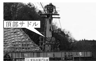
図-11 サドル設置
