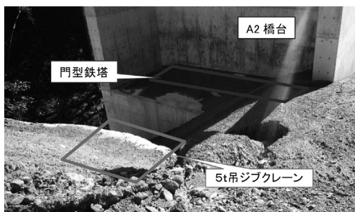
図-3 ジブクレーンの施工位置
