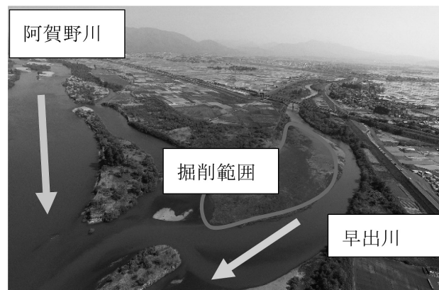
図-1 合流点の掘削範囲位置
