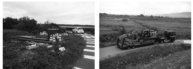
図-4 資材引上げ、重機搬出状況
