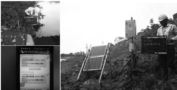
図-2 上流側に水位計の設置
