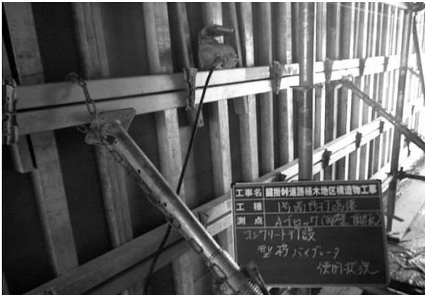
図-11 型枠振動機の使用状況
