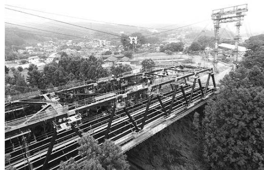
図-7 落とし込み架設状況
