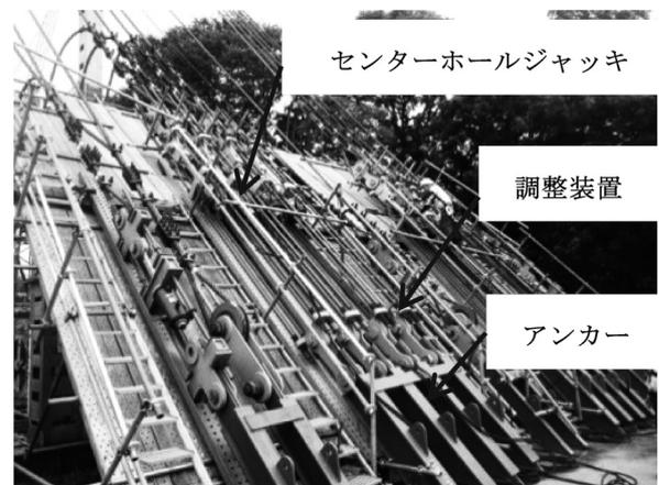
図-5 鉄塔調整装置 (A1)
