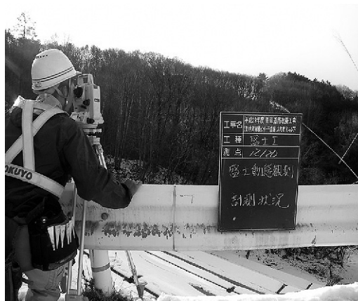
図-8 動態観測計測状況
