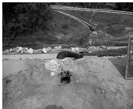
図-4 仮設排水設置状況
