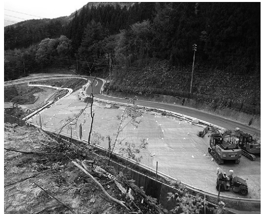
図-3 盛土工施工箇所シート養生
