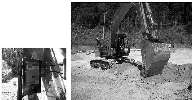
図-10 MCバックホウによる盛土施工状況
