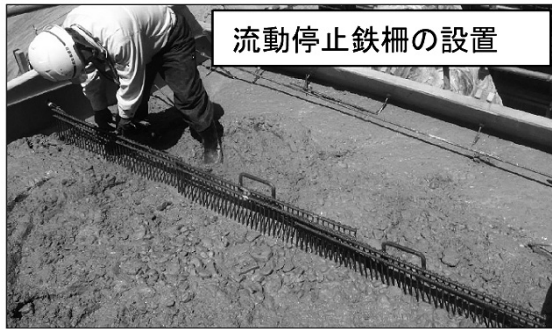
図-10 流動停止鉄柵設置状況
