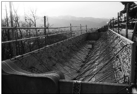
図-3 型枠内部の様子（作業通路確保困難）
