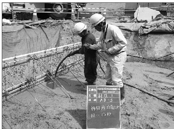
図-6 10～15秒間締固め実施状況
