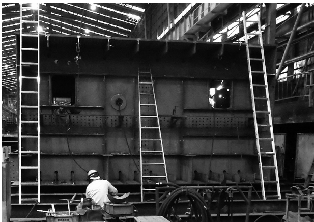
図-3 大型箱桁断面の一体組立
