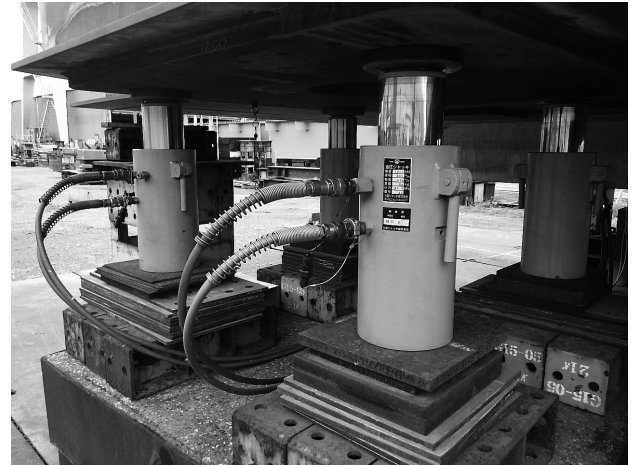
図-8 支点位置でのジャッキアップ状況
