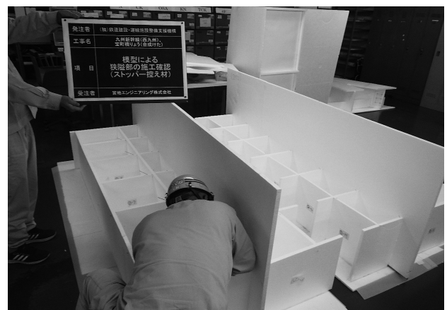
図-5 モックアップによる溶接作業性の確認
