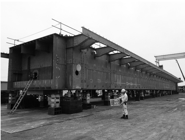
図-7 支点支持仮組立状況
