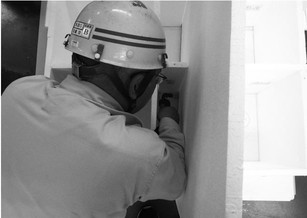
図-6 モックアップによる溶接作業性の確認
