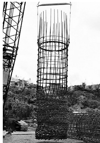
図-2 鉄筋かごの座屈事例①
