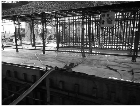
図-10 湛水養生状況
