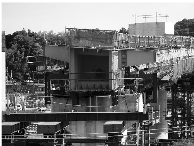
図-8 支点上のずれ止め
