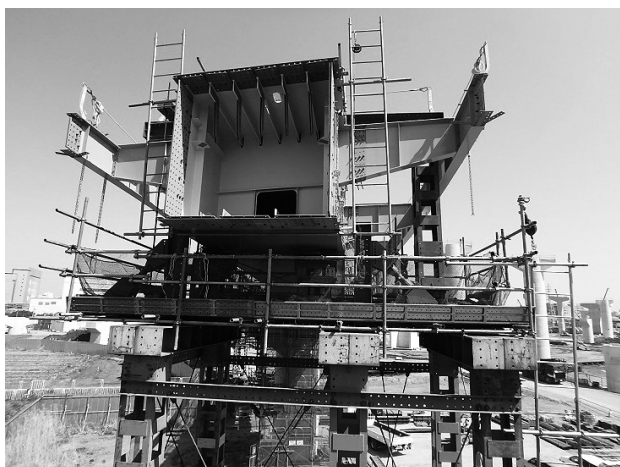
図-9 ベント上のずれ止め
