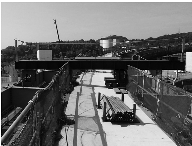
図-5 桁の倒れ抑制設備
