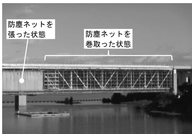
図-6 台風接近時の防塵ネットの巻取り
