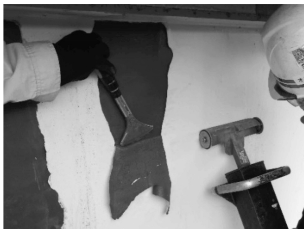
図-4 「IH工法」による塗膜除去状況
