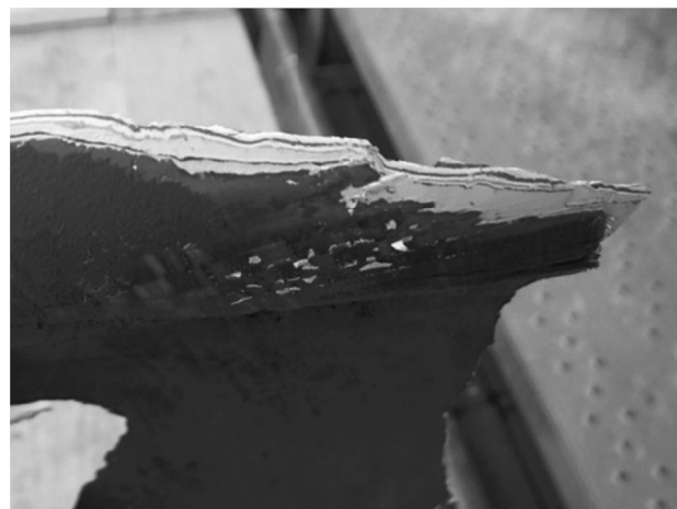
図-9 「IH工法」で除去した塗膜の状態
