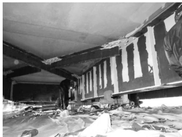
図-8 「IH工法」による塗膜除去状況
