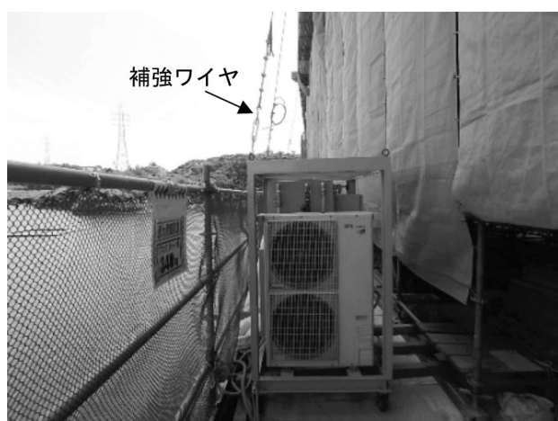
図-7 足場のワイヤによる補強
