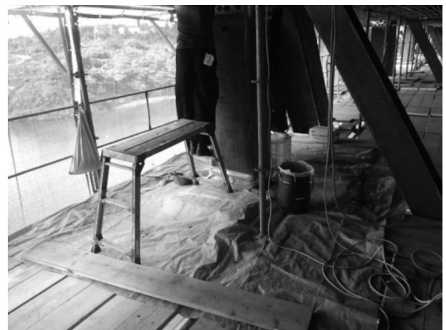
図-12 中段部の作業足場床隙間のふさぎ
