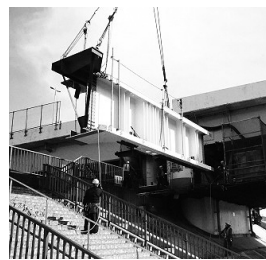
図-10 河川側ブロックの横取り
