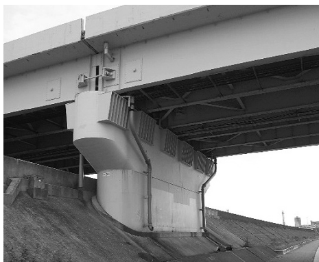
図-2 既設小304橋脚 (当初)
