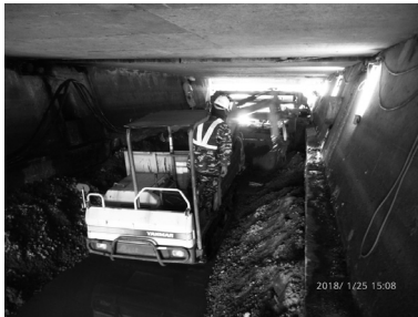
図-8 前方掘削・積み込み状況
