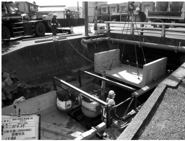
図-11 U型水路吊降ろし状況
