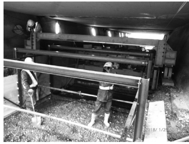
図-9 砕石基礎・土留組立状況
