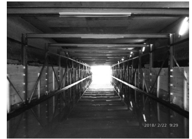
図-10 H鋼横矢板土留め完了
