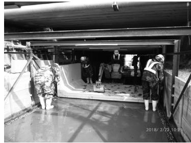
図-12 U型水路横引き状況
