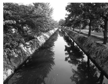
図-1 既設水路と周辺の状況
