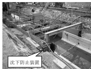
図-5 OSJ機と沈下防止装置
