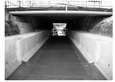
図-13 橋梁区間U型水路完了
