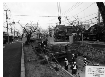
図-4 標準区間の施工状況
