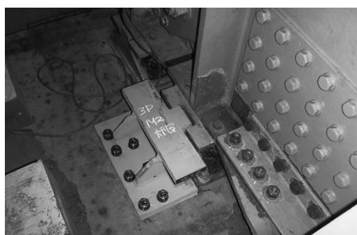
図-11 移動制限装置設置状況
