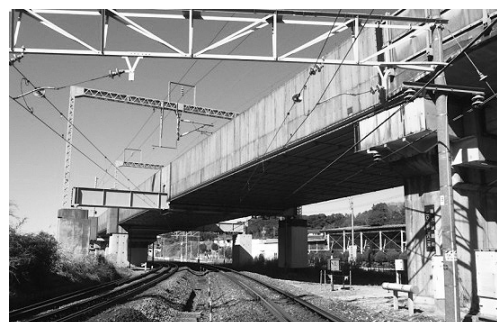
図-2 満水橋梁現場状況（さく外）
