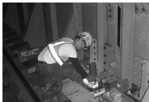
図-13 溶接部切断状況
