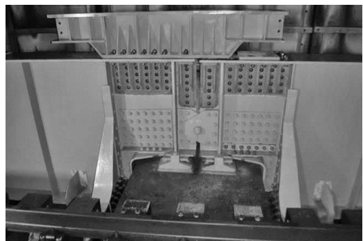
図-5 セッティングビーム設置完了
