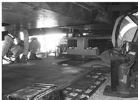
図-4 新設支承引込み状況
