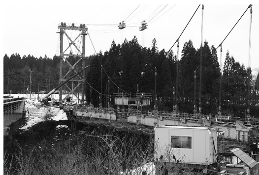
図-11 補剛桁撤去状況
