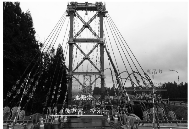
図-6 ケーブル定着状況
