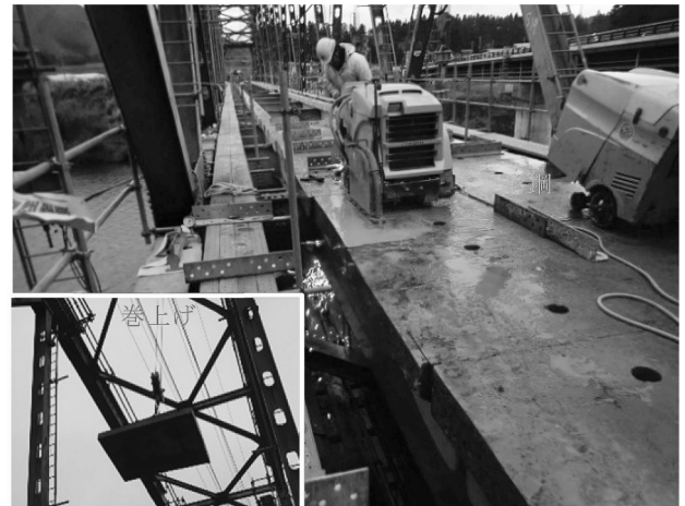
図-8 床版切断・撤去状況
