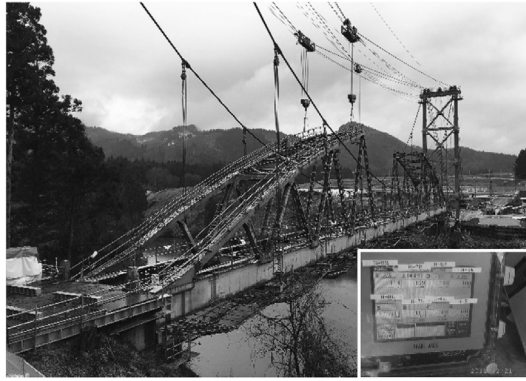
図-10 アーチリブ撤去状況
