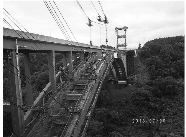
図-6 アーチリブ架設状況
