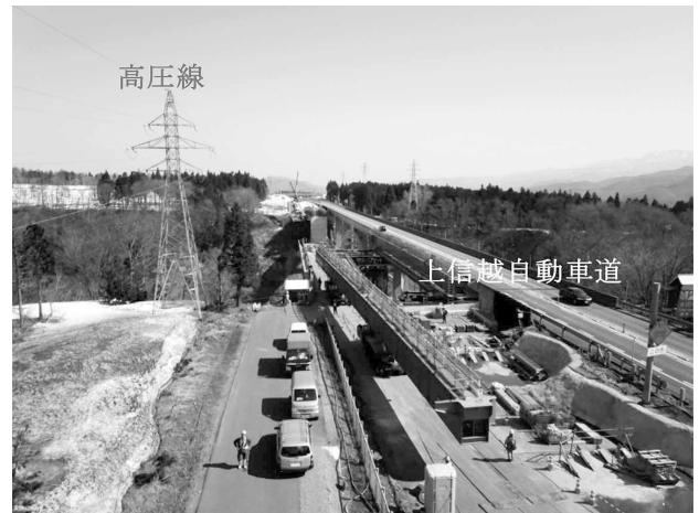
図-2 A1側 側径間架設状況
