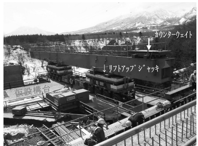
図-4 A2側側径間架設状況
