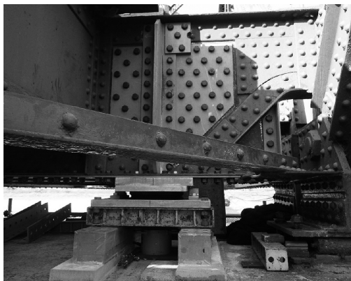
図-8 仮受支承設置状況
