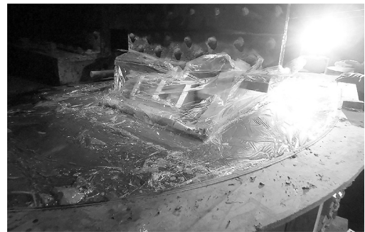
図-11 ラップフィルム施工状況
