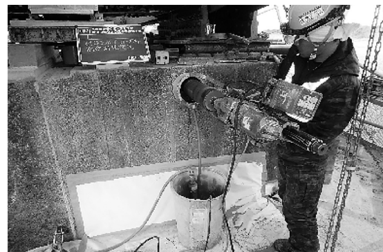
図-6 コアドリル側面方向 施工状況
