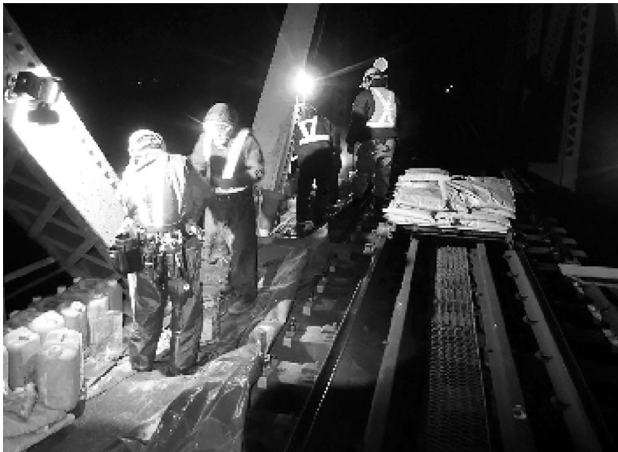
図-9 超速硬性高強度無収縮モルタル施工状況
