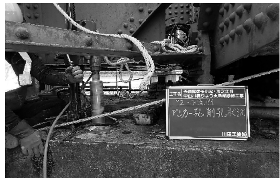
図-5 コアドリル鉛直方向 施工状況
