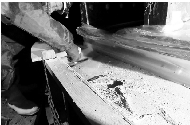
図-10 タンピング、表面再仕上げ状況
