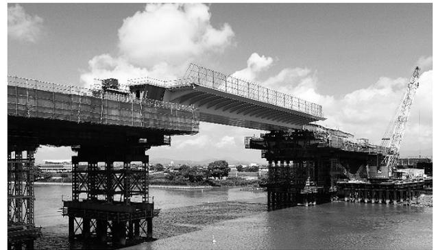
図-8 送り出し架設完了
