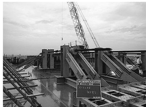
図-6 水平方向引き込み装置
