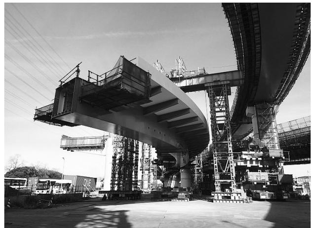
図-4 地組桁吊上げ
