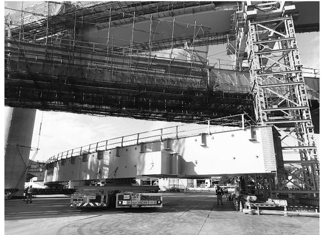
図-3 地組桁ヤード内移動
