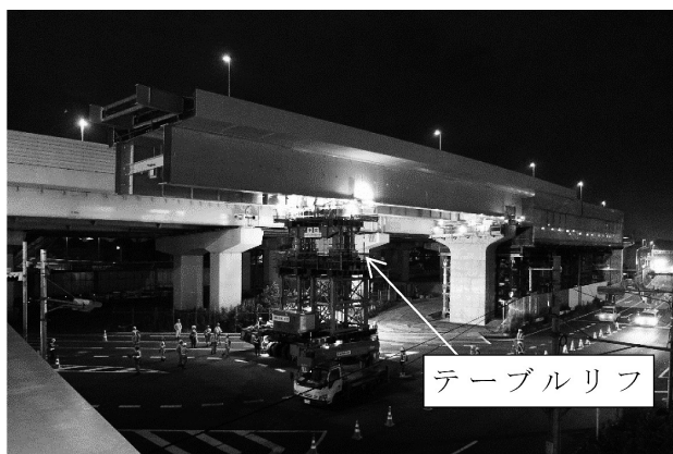
図-7 送出し架設状況
