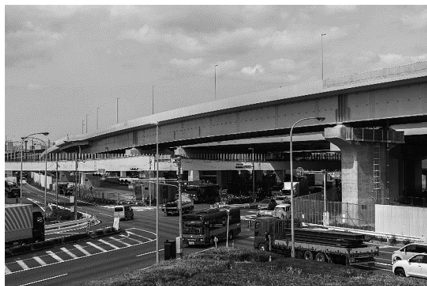
図-9 工事完了写真
