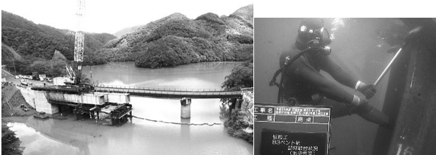
図-8 水位上昇のため水中施工にて部材取付(防水型トルクレンチにて締付確認)
