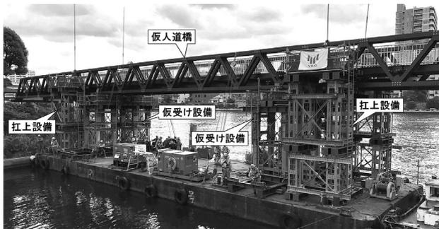
図-8 扛上設備と仮受け設備
