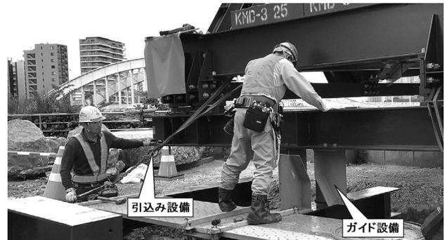
図-9 引込み設備とガイド設備
