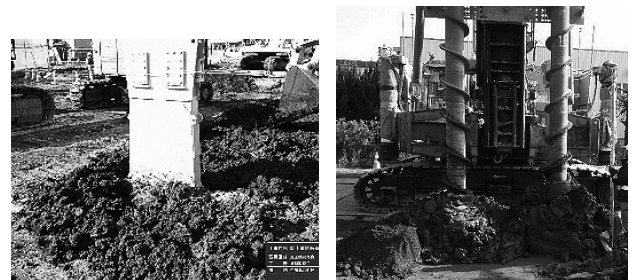
図-1 盛上り土発生状況 (左：SCM工法、右：RMP-MST工法)
