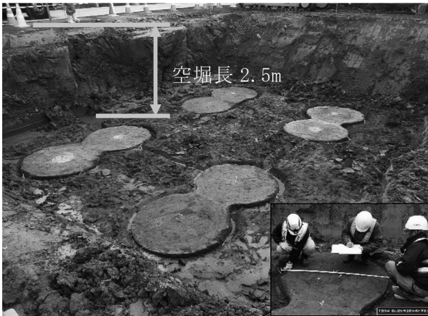
図-2 RMP-MST工法 杭頭出来形確認状況
