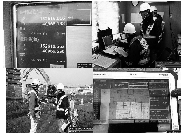
図-3 GNSSステアリングシステム (上：RMP-MST工法、下：SCM工法)
