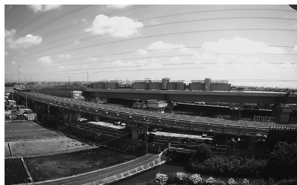
図-5 完了時全景
