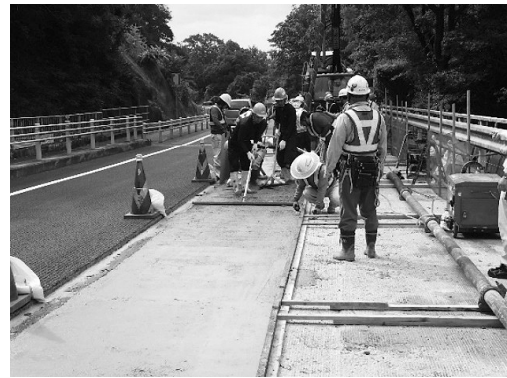
図-5 コンクリート打設状況
