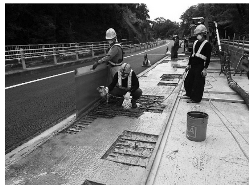
図-4 エポキシ樹脂系接着剤塗布状況
