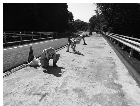
図-1 床版上面打音検査状況
