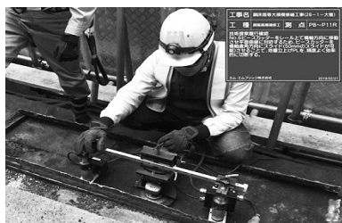
図-3 改造型レール付きピースカッター
