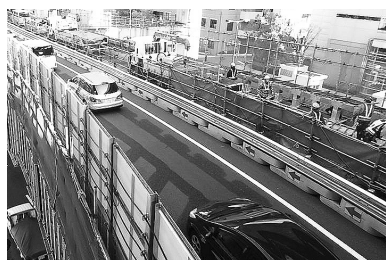
図-7 固定規制と防護状
