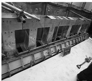
図-4 高欄先行建込
