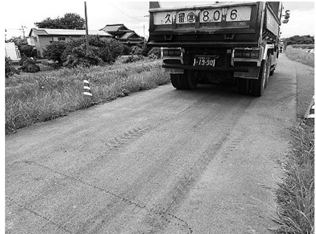
図-3 合材運搬ダンプ運搬状況
