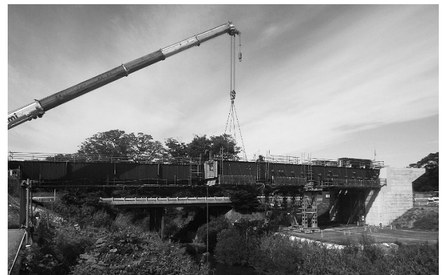
図-5 張り出し架設状況
