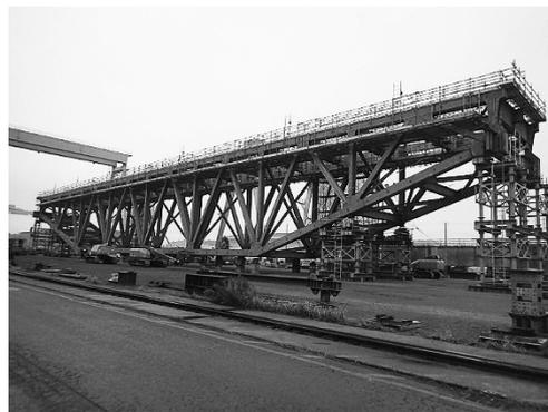
図-2 工場仮組立完了時全景
