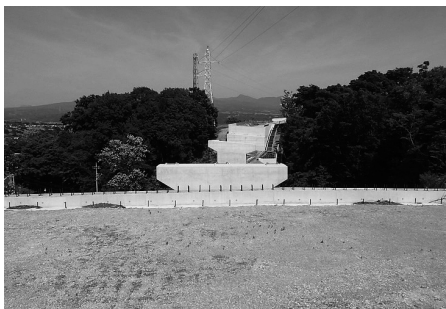
図-1 施工前状況
