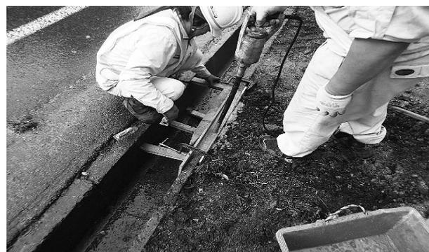
図-7 破損水路補修
