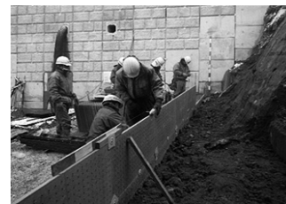
図-5 内部から組立作業
