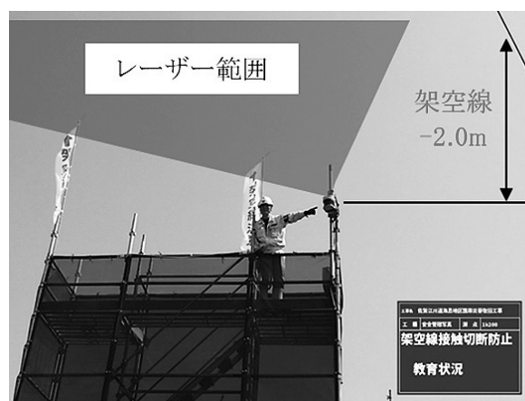
図-5 『レーザーバリアシステム』設置
