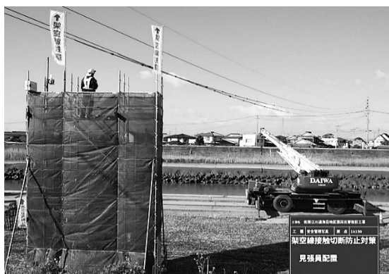
図-4 架空線見張り状況
