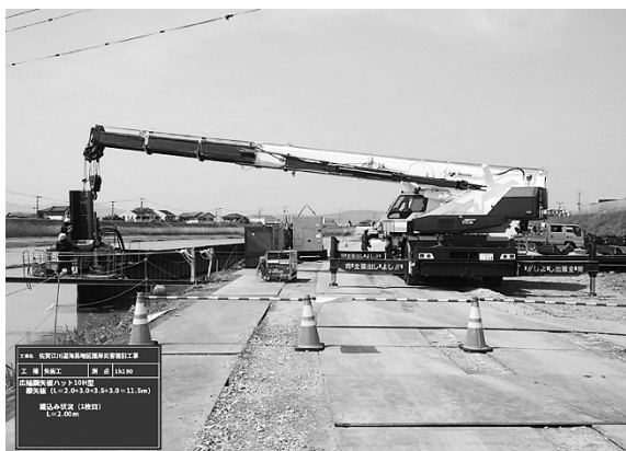
図-3 架空線下継ぎ矢板圧入状況
