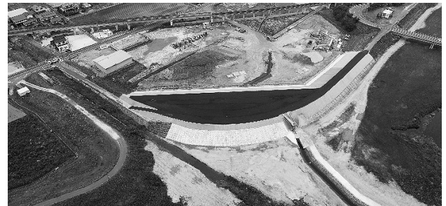
図-2 工事完成(空撮による全景)
