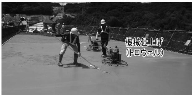
図-1 検測棒撤去後の仕上げ状況例
