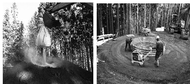
図-1 改良土埋戻し状況
