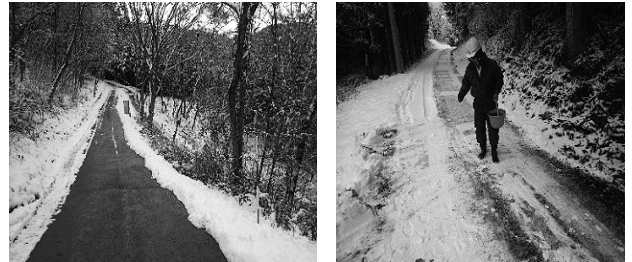
図-4 路肩部ポール設置、塩カル散布
