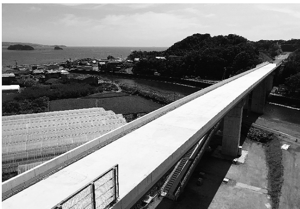
図-1 田辺西バイパス芳養高架橋
