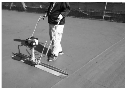
図-4 振動機付締固め機（実機）
