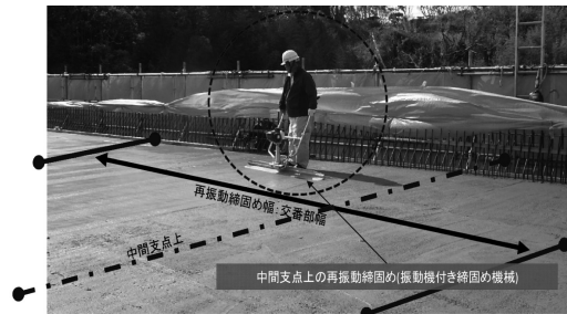
図-6 あとタンピング施工範囲と状況
